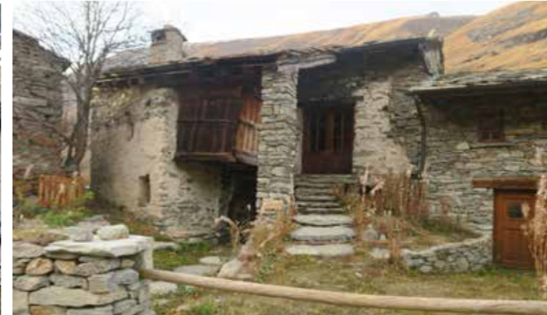
L'Ecot à 2000 m d'altitude. Les maisons du hameau sont basses, couvertes de lauzes / Source : Atelier UO
