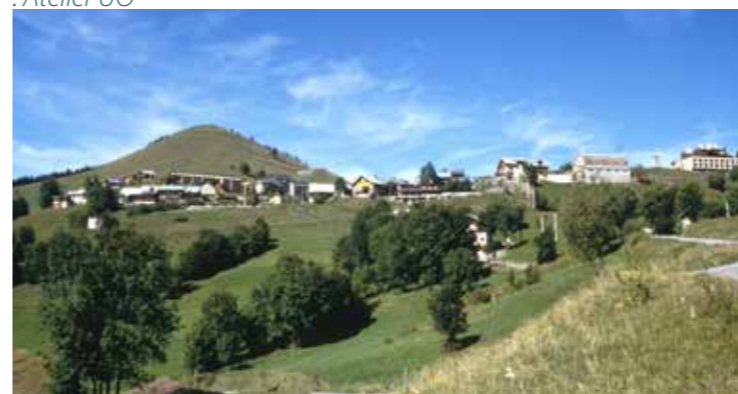
Albiez le jeune - village station implanté en crête / Source : UDAP (1998)
