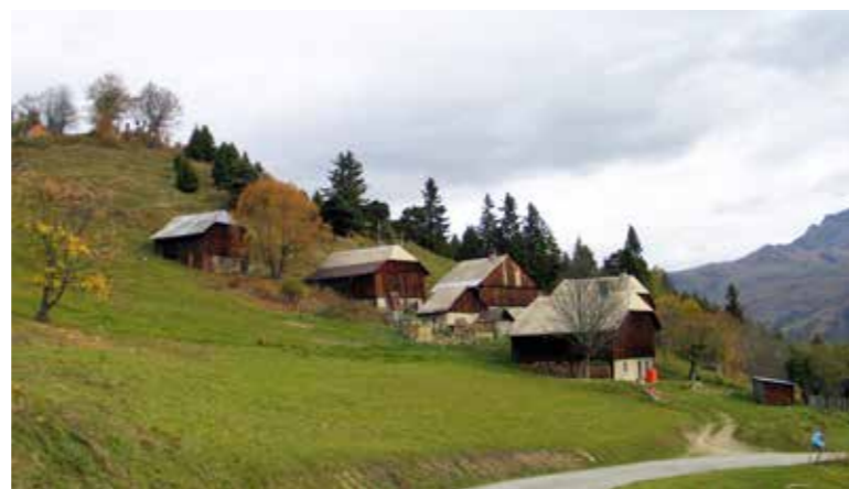
Montgellafrey - fermes en bois / Source : CAUE de la Savoie
