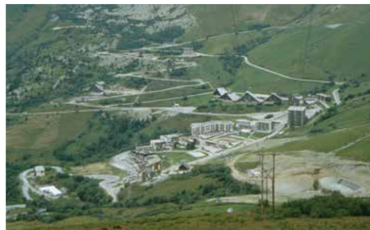
Longchamp 1650, un étagement de l'habitat collectif dans la pente / Source : UDAP (1998)
