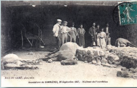
Sommières (Gard) ; victimes de l'inondation du 26 septembre 1907.
