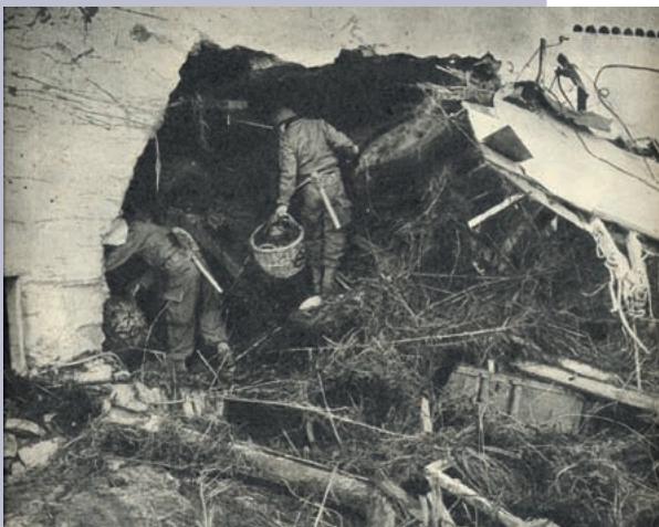
Dégâts de la catastrophe de Malpasset [source : Paris Match]
